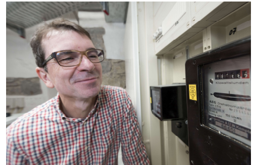
© energie & umweltzentrum allgäu Leistungsfähigkeit führt auch bei höherem Verbrauch.
